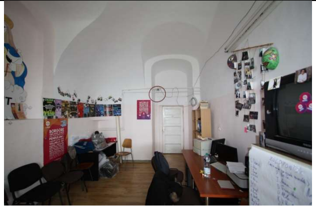
TRONSON A - PARTER, BOLTA BOEMA CU INTERSECTII (FOSTUL REFECTORIU)
