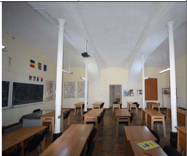
TRONSON C - PARTER, BOLTI BOEME CU ARCE DUBLOURI COMPUSE, CURBURA VARIABILA, STALPI FONTA
