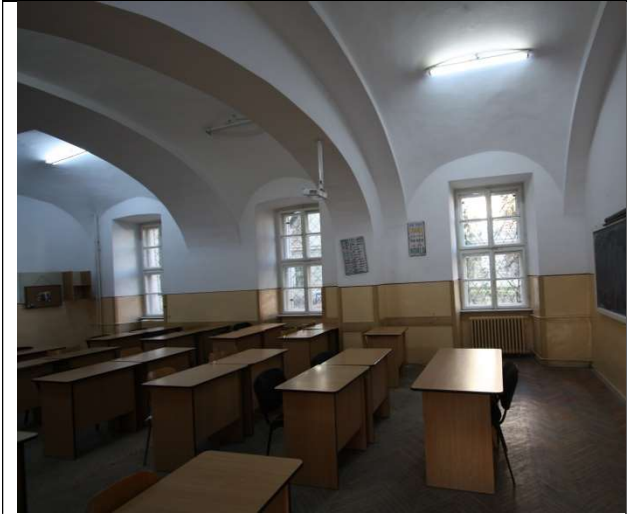
TRONSON A - PARTER, BOLTI BOEME CU ARCE DUBLOURI COMPUSE, CURBURA VARIABILA
