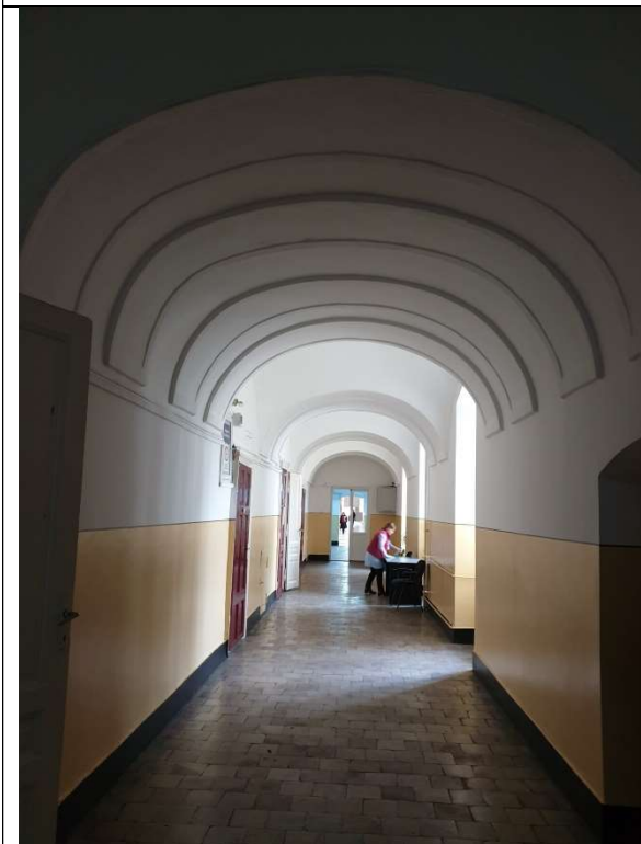
TRIONSON A - CORIDOR, BOLTA CILINDRICA CU ARCE DUBLOURI SPRIJINITE CILINDRICA
