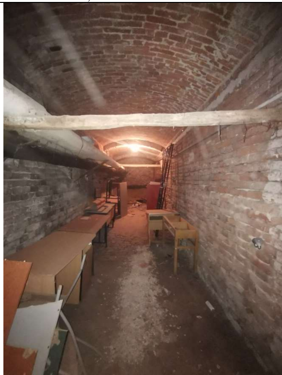
TRONSON C- SUBOL-BOLTA CILINDRICA
