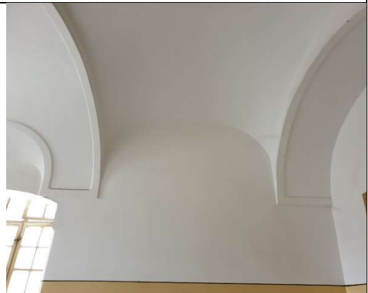
TRIONSON A – CASA SCARII, BOLTI BOEME, ALTERNATE CU BOLTI CILINDRICE CU INTERSECTII
