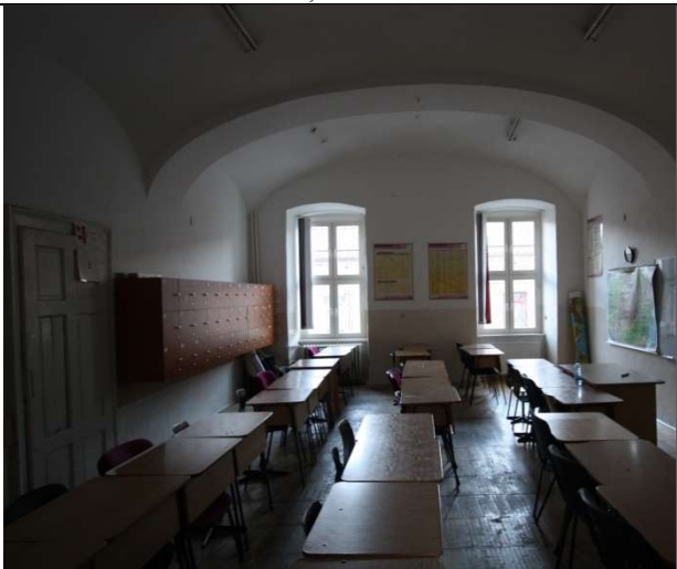
TRONSON A - PARTER, BOLTI BOEME CU ARCE DUBLOURI SIMPLE, CURBURA VARIABILA
