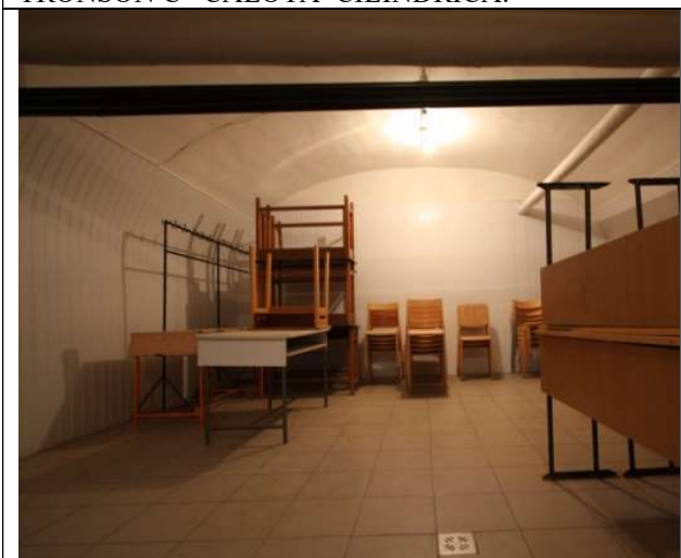
TRONSON C- SUBOL-CALOTA CILINDRICA
