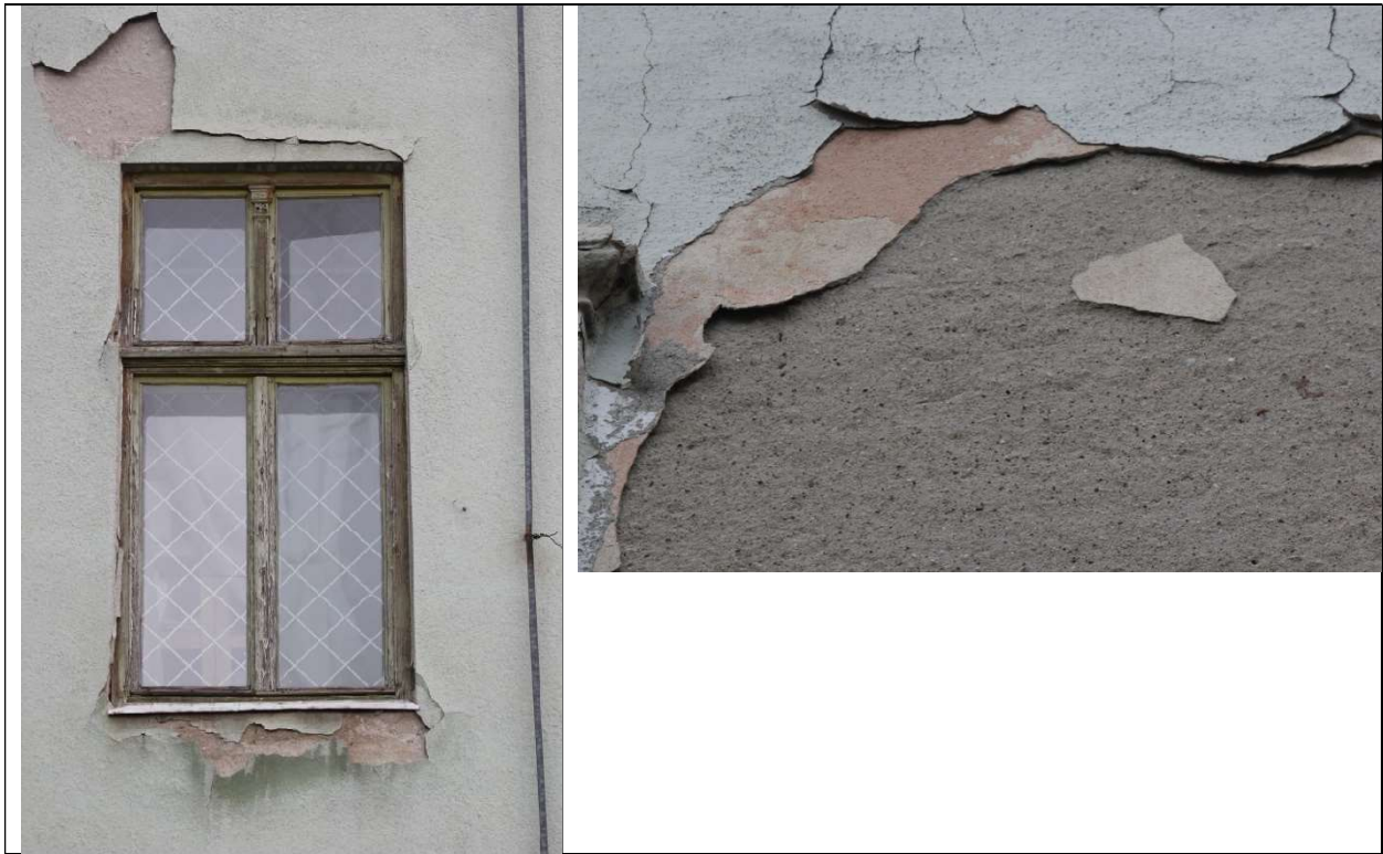
ZUGRAVEALA VECHЕ GASITA SUB TENCUIALA NOUA – INFORMATIE VALOROASA PENTRU STABILIREA CULORII FATADEI PROPUSE
