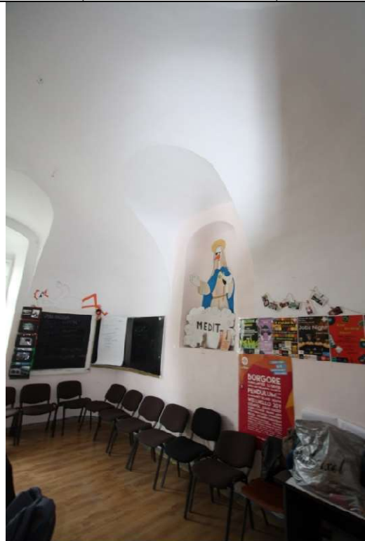
TRONSON A - PARTER, BOLTA BOEMA CU INTERSECTII (FOSTUL REFECTORIU)
