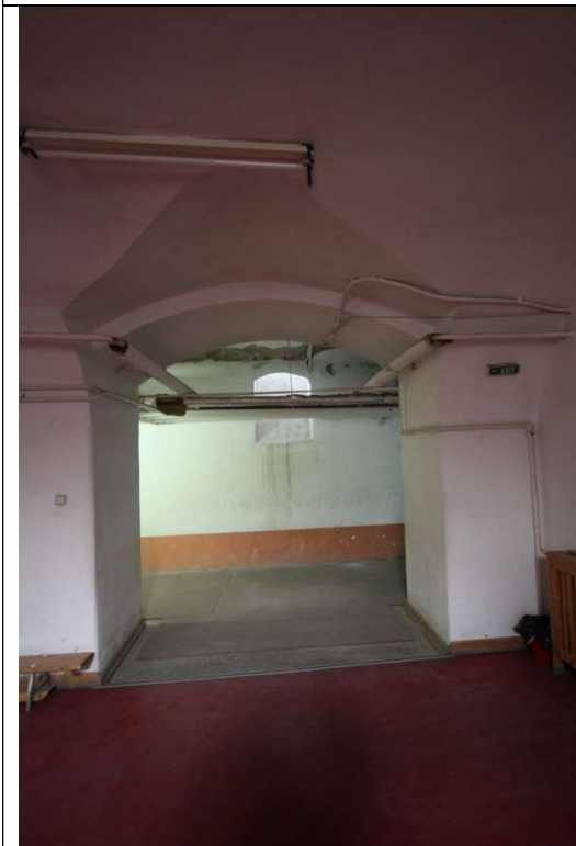
TRONSON B - SUBSOL, CORIDOR, BOLTA CILINDRICA CU INTERSECTII
