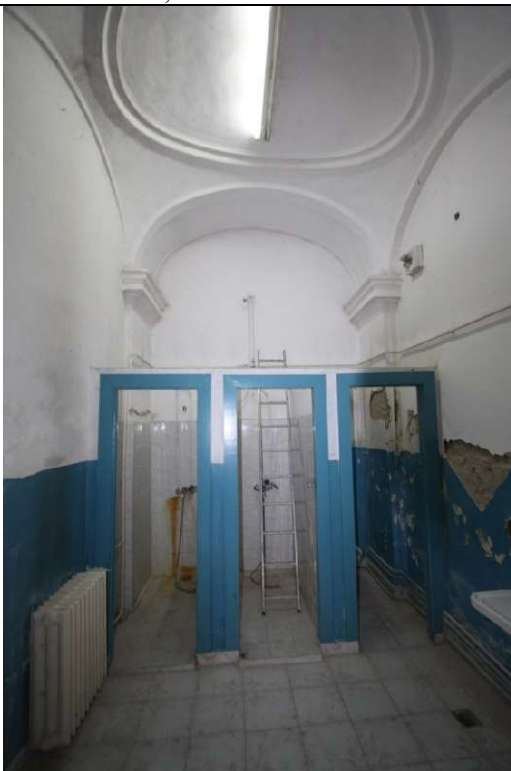
TRONASON A PARTER ZONA CASA SCARII- BOLTA BOEMA, ARCE COLINDRICE LATE CU INTERSECTII, CU MEDALION
