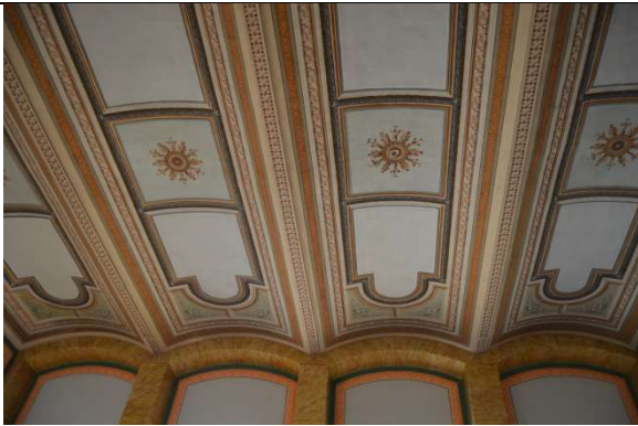
TRONSON B – ETAJ 1, GRINZI METALICE, BOLTI CILINDRICE
