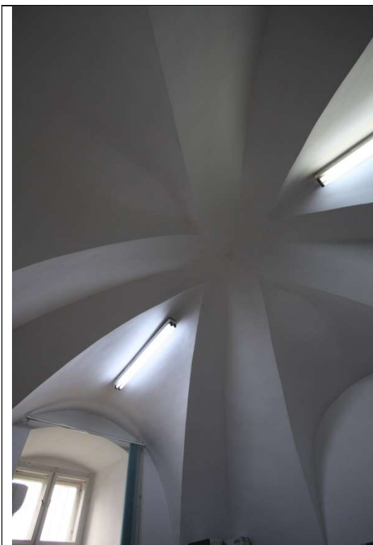
TRONSON A - ETAJ 1, BOLTA GOTICA IN CRUCE, CU INTERSECTII (CU BOLTA CILINDRICA)
