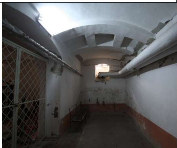
TRONSON B- SUBSOL – BOLTA CILINDRICA, ARC DUBLU
