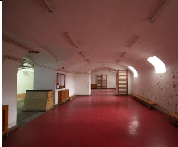
TRONSON B – SUBSOL, BOLTA CILINDRICA, ARCE DUBLE , PILASTRII CU CAPITEL
