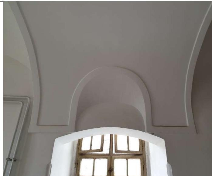
TRIONSON A – CASA SCARII, BOLTI BOEME, ALTERNATE CU BOLTI CILINDRICE CU INTERSECTII
