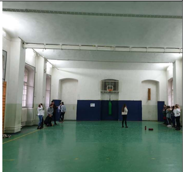
TRONSON B – PARTER –SALA SPORT, GRINZI METALICE, BOLTISOARE CILINDRICE
