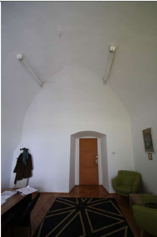
TRONSON A –ETAJ 1 – LUNETA CILINDRICA CU INTERSECTII
