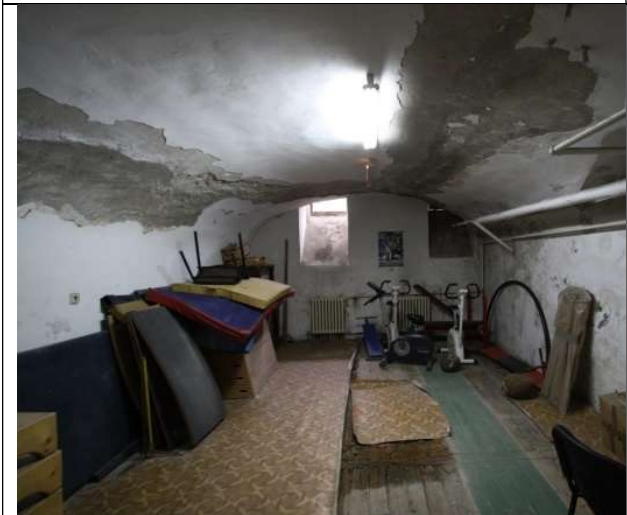
TRONSON C –CALOTA CILINDRICA.
