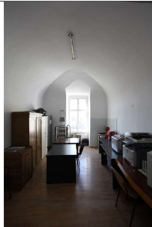
TRONSON B –ETAJ 1 – LUNETA CILINDRICA CU INTERSECTII
