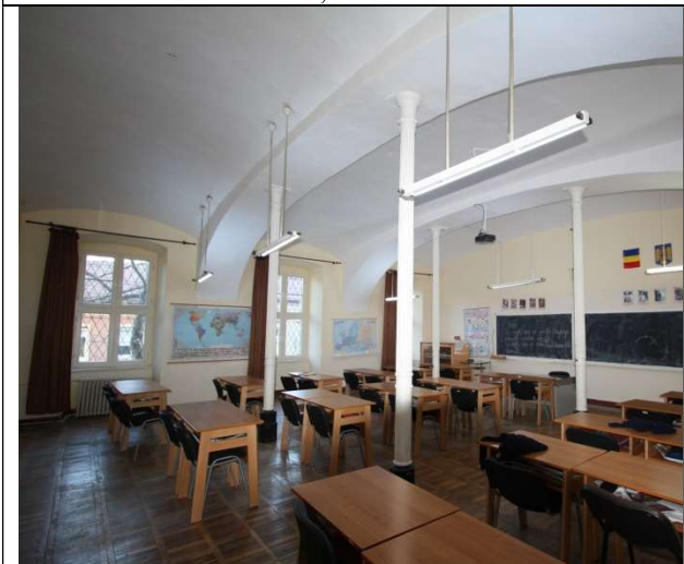
TRONSON C - PARTER, BOLTI BOEME CU ARCE DUBLOURI COMPUSE, CURBURA VARIABILA, STALPI FONTA
