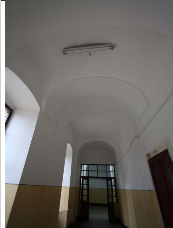
TRONSON A - PARTER, BOLTA CILINDRICA, ARC CURBURA VARIABILA
