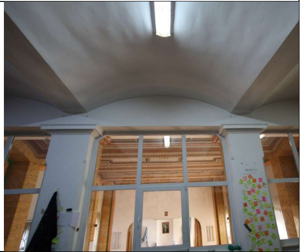
TRONSON B – ETAJ 1, ETAJ 2 GRINZI METALICE, BOLTI CILINDRICE
