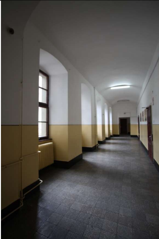
TRONSON C – ETAJ 1, CORIDOR, BOLTA CILINDRICA
