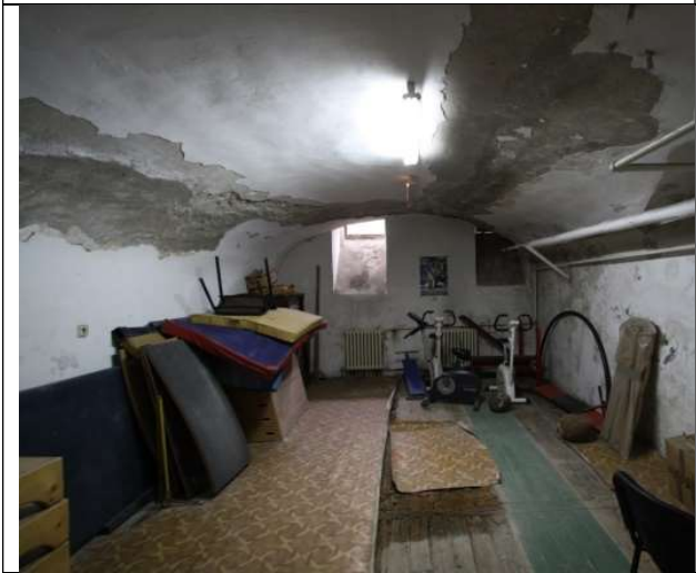
TRONSON C –CALOTA CILINDRICA.
