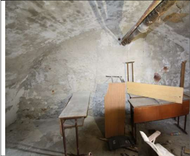
TRONSON A SUBSOL-BOLTA CILINDRICA
