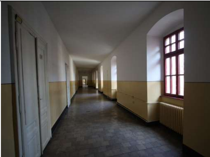
TRONSON C – ETAJ 1, CORIDOR, BOLTA CILINDRICA
