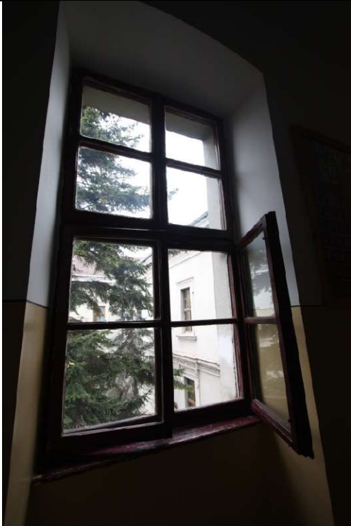
FERESTRE CUPLATE TIP „TECHAUER” REALIZATE IN SEC XX, DE CALITATE FOARTE PROASTA, CU FERONERII SLABE SI NEPERFORMANTE
