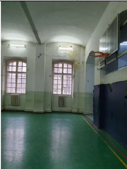
TRONSON B – PARTER –SALA SPORT, GRINZI METALICE, BOLTISOARE CILINDRICE
