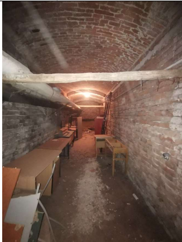
TRONSON C- SUBOL-BOLTA CILINDRICA
