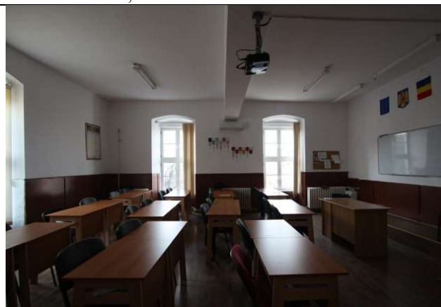
TRONSON B – ETAJ 2, CORIDOR, PLANSEU BETON
