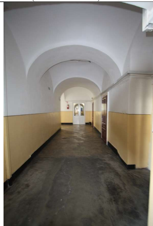
TRONSON A – ETAJ1, CORIDOR, BOLTA BOEMA CU ARC DUBLOU
