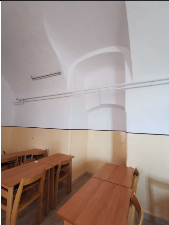
TRONSON A - PARTER, BOLTA BOEMA CU INTERSECTII (FOSTUL REFECTORIU)
