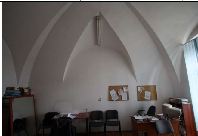
TRONSON A - ETAJ 1, BOLTA GOTICA IN CRUCE, CU INTERSECTII (CU BOLTA CILINDRICA)
