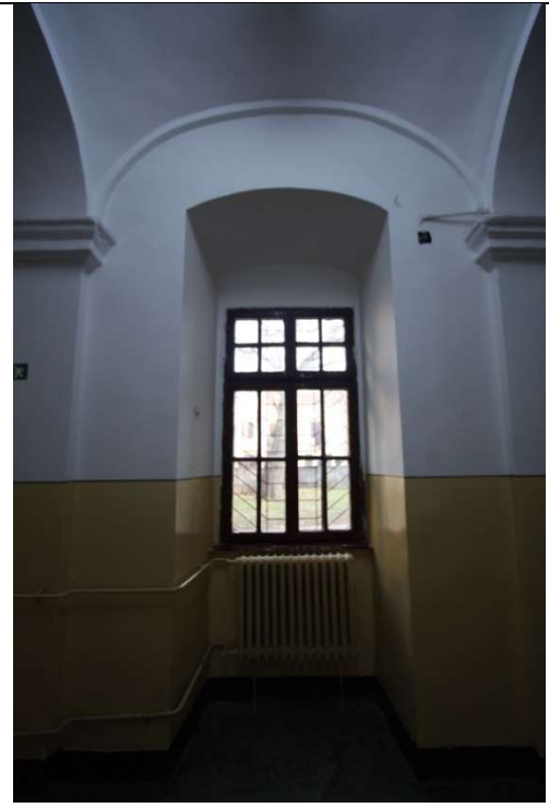
TRONSON A – PARTER, CORIDOR, BOLTA CILINDRICA, CU ARCE DUBLOURI SPRIJINITE PE PILASTRII CU CAPITEL
