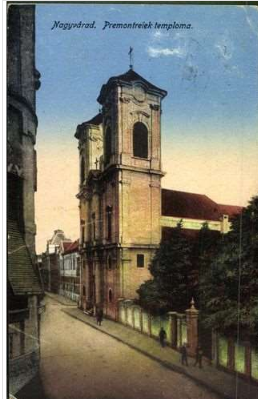
Imagine din anul 1914 a Bisericii Premonstratense „Maica Îndurerată. Vechea poarta de acces spre curtea manastirii este modificata. In fundal se vede si corpul 2 al cladirii postei terminat in anul 1911.
