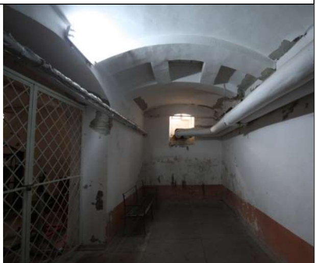
TRONSON B- SUBSOL – BOLTA CILINDRICA, ARC DUBLU
