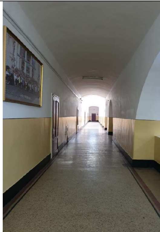
TRONSON B – ETAJ 1, CORIDOR, BOLTA CILINDRICA
