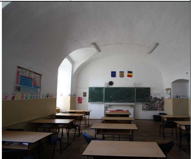
TRONSON A - PARTER, BOLTI BOEME CU ARCE DUBLOURI SIMPLE, CURBURA VARIABILA
