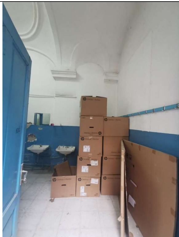
TRONASON A PARTER ZONA CASA SCARII- BOLTA BOEMA, ARCE COLINDRICE LATE CU INTERSECTII, CU MEDALION
