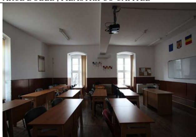
TRONSON B – ETAJ 2, CORIDOR, PLANSEU BETON
