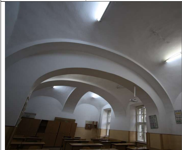
TRONSON A - PARTER, BOLTI BOEME CU ARCE DUBLOURI COMPUSE, CURBURA VARIABILA
