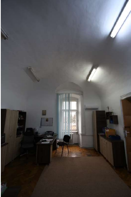
TRONSON A –ETAJ 1 – LUNETA CILINDRICA CU INTERSECTII
