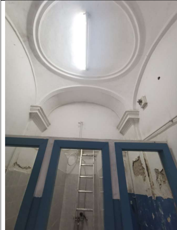
TRONASON A PARTER ZONA CASA SCARII- BOLTA BOEMA, ARCE COLINDRICE LATE CU INTERSECTII, CU MEDALION
