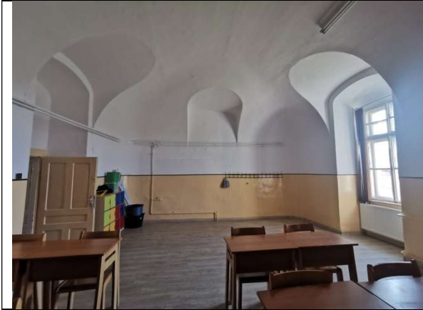
TRONSON A - PARTER, BOLTA BOEMA CU INTERSECTII (FOSTUL REFECTORIU)
