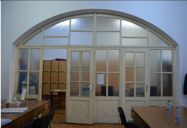
FERESTRE CUPLATE TIP „TECHAUER” REALIZATE IN SEC XX, DE CALITATE FOARTE PROASTA, CU FERONERII SLABE SI NEPERFORMANTE
