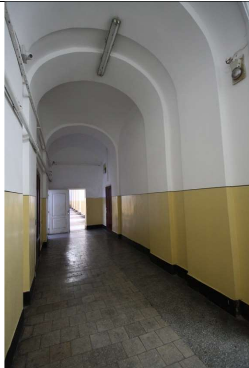
TRONSON A - CORIDOR, BOLTA CILINDRICA CU ARCE DUBLOURI SPRIJINITE PE PILASTRII
