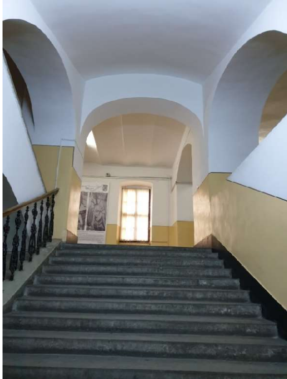
TRONSON B- CASA SCARII, BOLTA BOEMA INCLINATA, ARCE INCLINATE
