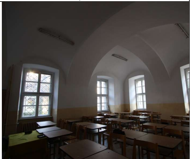
TRONSON A - PARTER, BOLTI BOEME CU ARCE DUBLOURI COMPUSE, CURBURA VARIABILA
