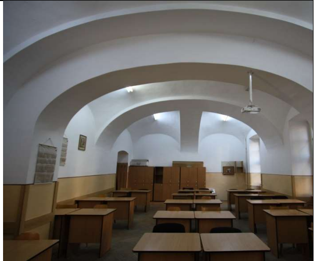
TRONSON A - PARTER, BOLTI BOEME CU ARCE DUBLOURI COMPUSE, CURBURA VARIABILA
