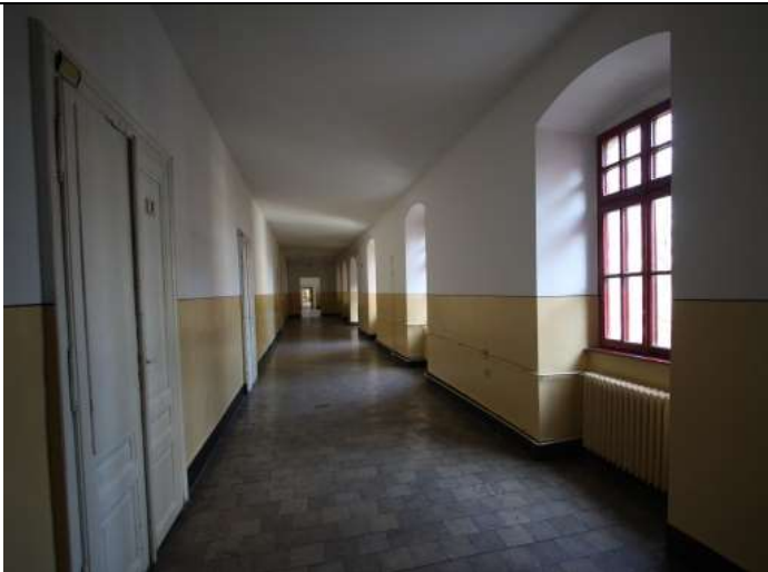
TRONSON C – ETAJ 1, CORIDOR, BOLTA CILINDRICA
