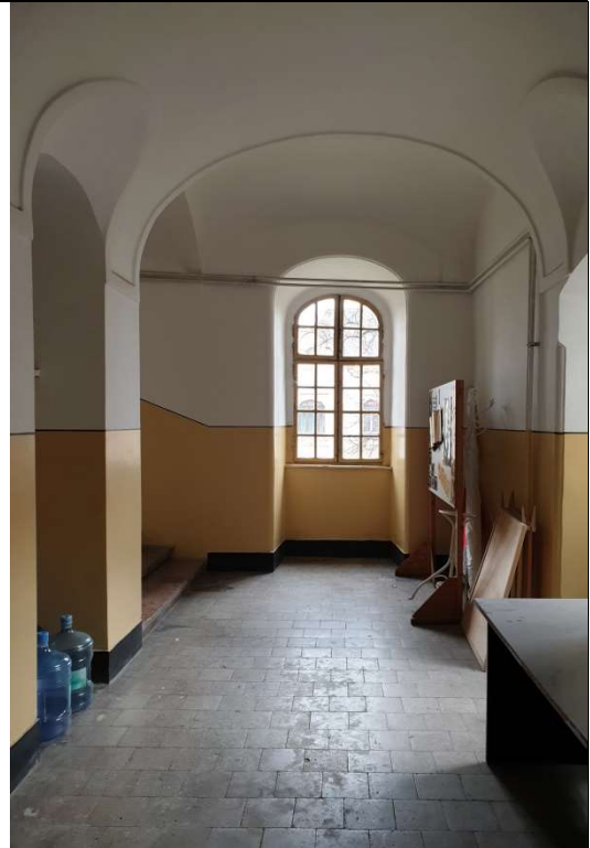
TRIONSON A – CASA SCARII, BOLTI BOEME, ALTERNATE CU BOLTI CILINDRICE CU INTERSECTII
