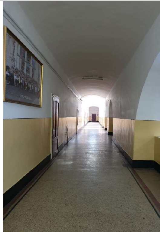
TRONSON B – ETAJ 1, CORIDOR, BOLTA CILINDRICA
